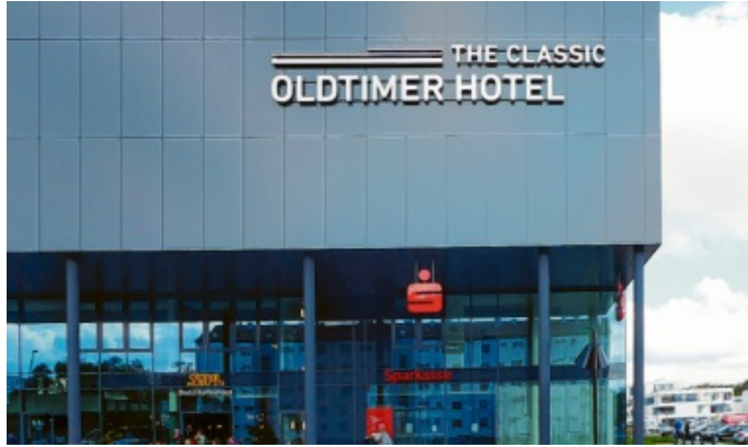
Die Fassade des Classic Oldtimer Hotels in Ingolstadt ist mit Alu-Leichtbauplatten von Metawell verkleidet. Foto: Metawell/oH
