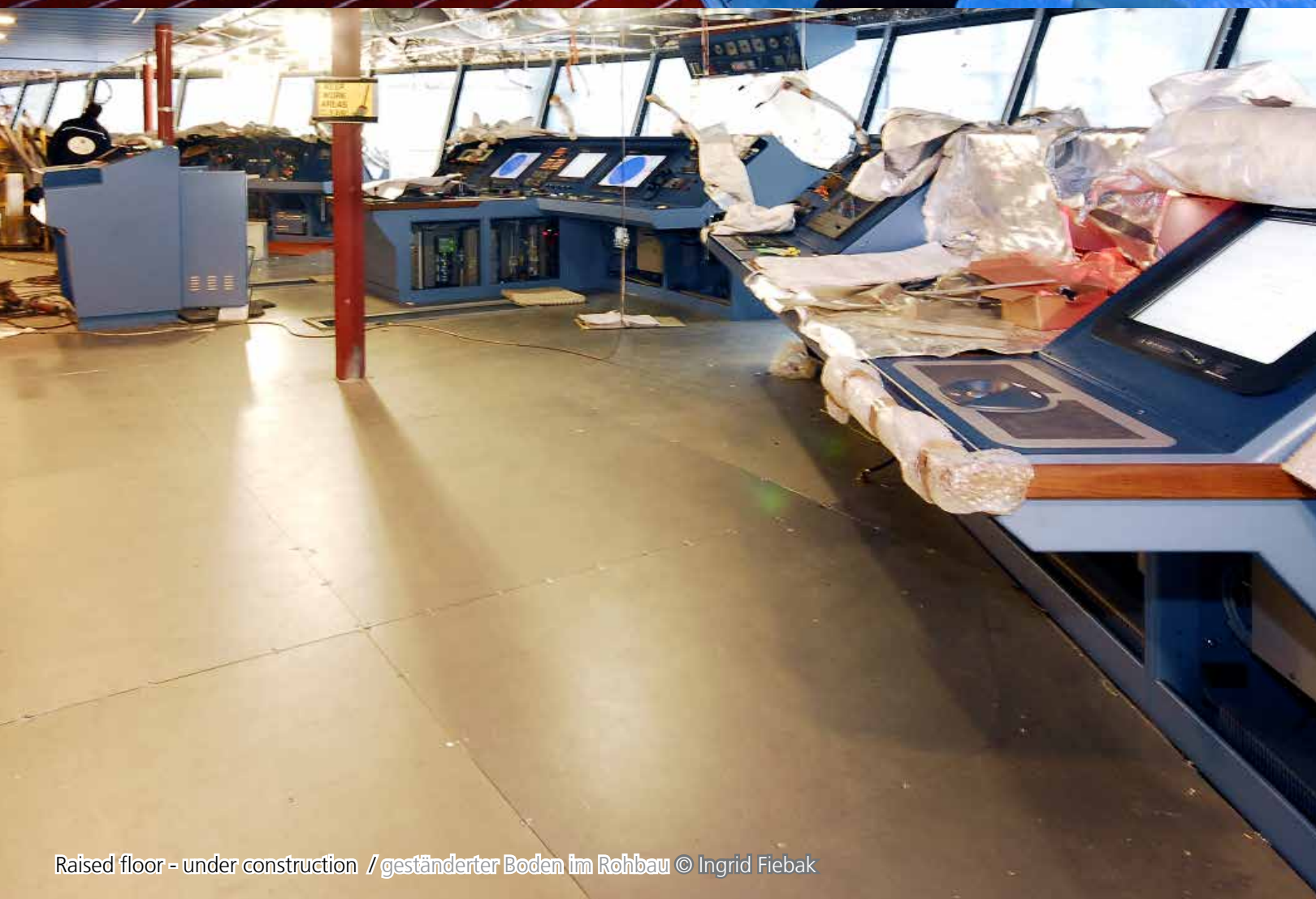
Raised floor / geständerter Boden © Ingrid Fiebak
