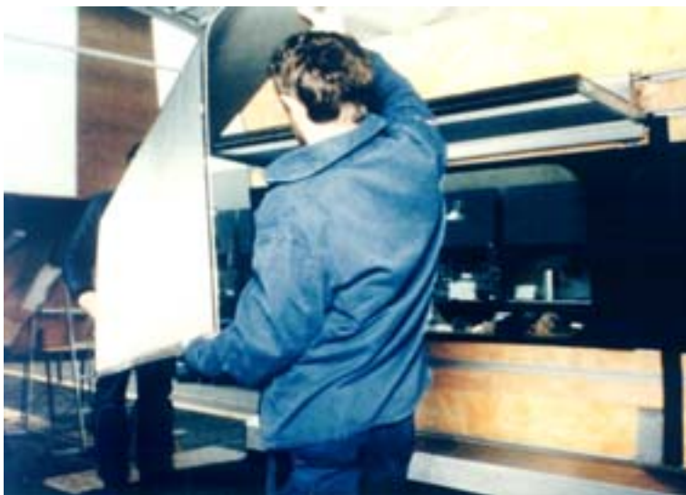
Gekrümmtes Aluflex als Deckenelement für ASCAN Oben: Montage Rechts: eingebaut
